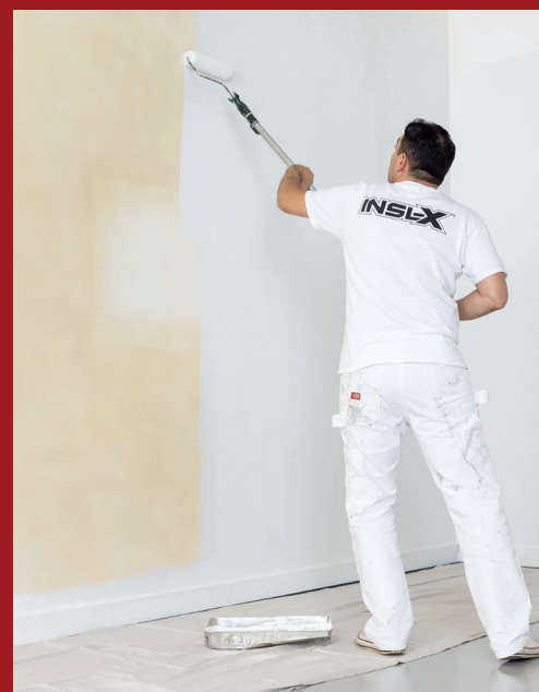
Mur recouvert de taches de nicotine
